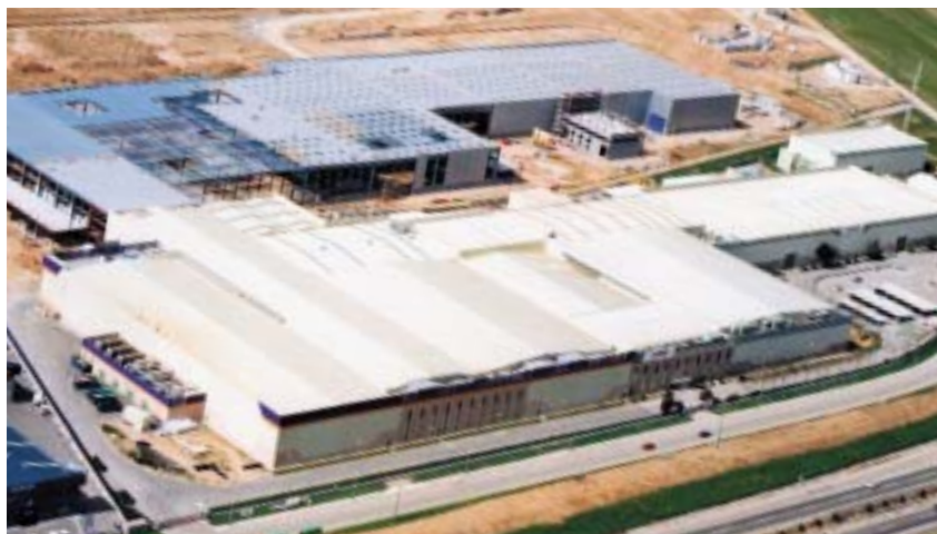
Vue aérienne de l'usine Airbus à Illescas.
