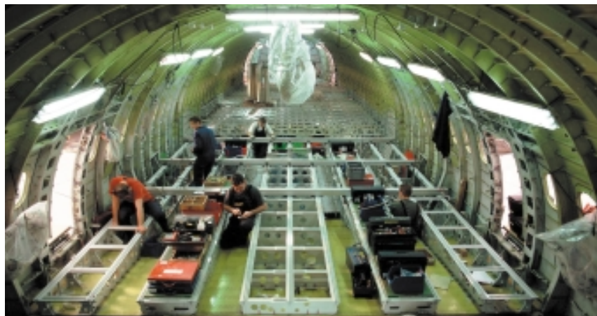
La nueva estructura del suelo debe soportar hasta 50 toneladas
