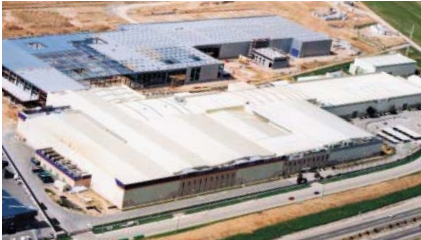
Vista aérea del Centro de Compuestos Avanzados de Airbus en Illescas (Toledo).
